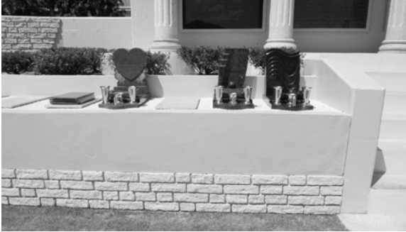
J南地区 集合型永代供養墓 合葬ではない個別納骨の永代供養墓。納骨室の蓋になるのが自由にデザインされた石塔。埋葬者の名前は下の壁に墓誌石版に刻んで貼り付ける。供養は霊園が様々な宗派によって年3回読経にて行う。但し埋葬できるのは3体まで。
