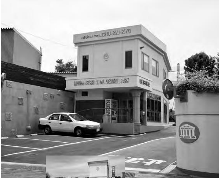
美原東ロイヤル新管理棟の外観
