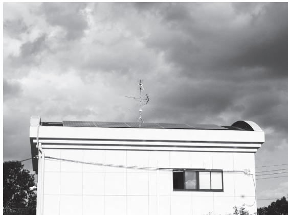
太陽光発電パネルが敷設された美原管理棟屋上
