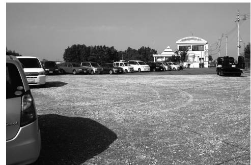
盛土である駐車場拡張地が十分に踏み固まる春の彼岸前に舗装を行なう予定です
